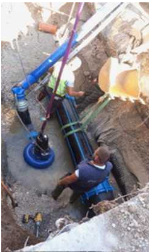
Sanacija kvara na potisnom kanalizacionom cijevovodu DN 500mm
